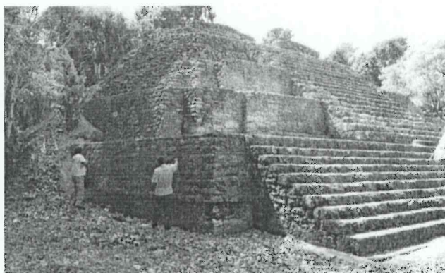
Foto 3. Edificio 4, Grupo Maler
