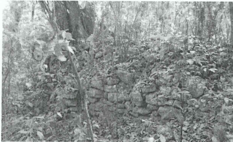
Foto 5. Sección de muro parcialmente expuesta en Paxte
